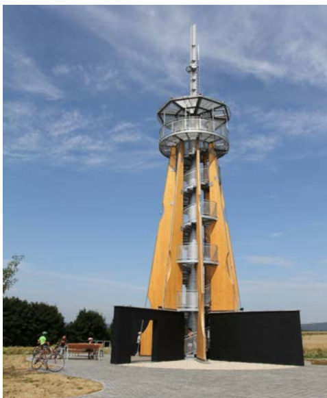
Wieża widokowa „Blahutovice” / Rozhledna „Blahutovice”
